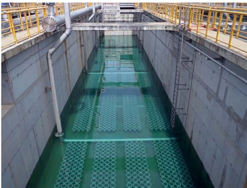
nera controlada, unas zonas de los tanques de aireación no cuentan con suministro de aire, pero sí mezcla, denominadas zonas anoxias. Se han construido cuatro (4) tanques de aireación. La Planta cuenta con seis (6) sopladores (cinco en operación y uno de reserva).
